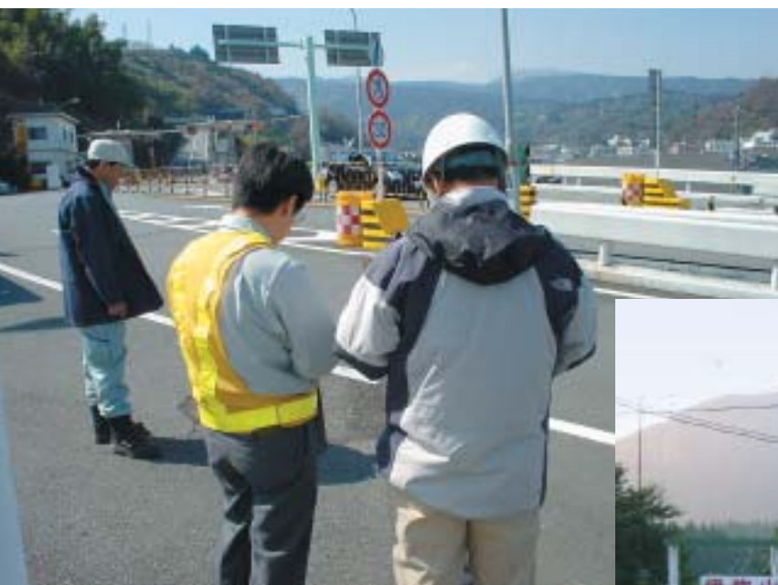
箱根ターンパイクで補修が必要な箇所を確認している様子 (写真: 右もマッコーリー・ジャパン)
